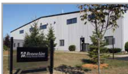
Fábrica EE.UU. - Wisconsin
